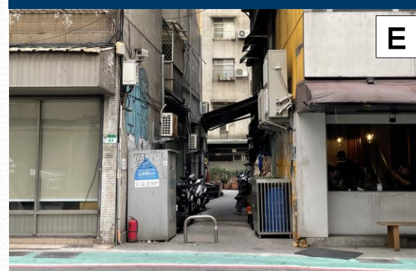
鄰棟間隔、耐震能力不足
